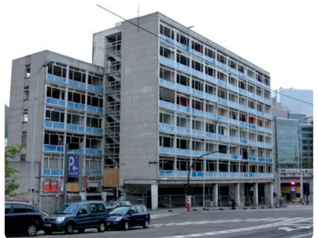
Place Saint-Lazare, à Saint-Josse-ten-Noode (Bruxelles). Abandonné, cet immeuble était occupé par des sans-papiers. Après son évacuation, manu militari par les forces de l'ordre, l'été dernier, les accès au bâtiment ont été murés et toutes les fenêtres ont été cassées pour s'assurer, question de « bonne gouvernance », qu'il ne sera pas réoccupé.
